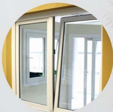
Janela Oscilobatente (Abre e Tomba) permite a folha do caixilho abrir (giro de até 180°) ou tombar para o lado interno, tornando versátil a ventilação do ambiente. Possui travamento multiponto graças ao sistema de câmara europeia. Além de muito moderna, arrojada e segura, esta tipologia possui ótima propriedade de vedação acústica.
